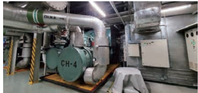
制冷設備的智能照明系統
